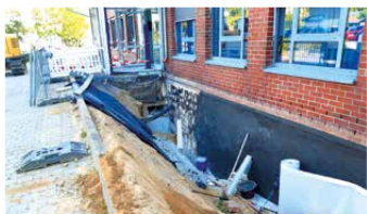
Wasserschadensanierung in Kesselsdorf
