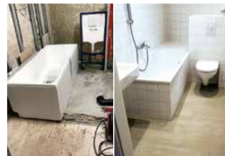
Badumbau in der Knorrstraße innerhalb einer grundlegenden Wohnungssanierung
