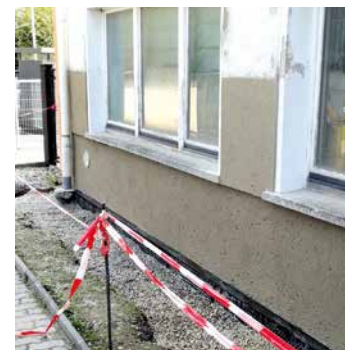
Abschluss unserer Arbeiten
