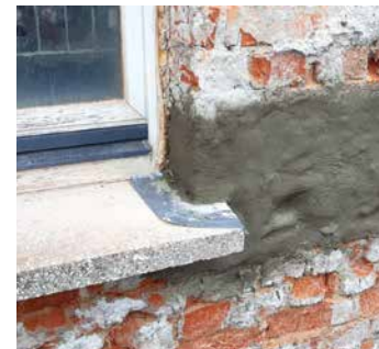
Dichtungsarbeiten im Detail
