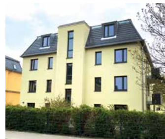
WiD-Neubau Nöthnitzer Straße
